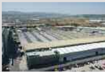
ΧΑΛΚΟΡ - Σωληνοουργείο, Οινόφυτα
